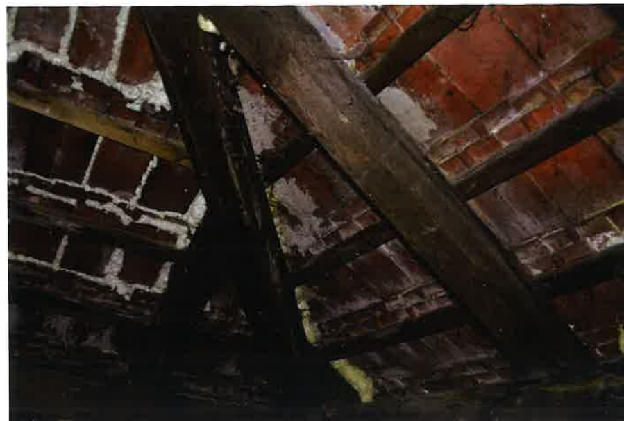
II. 56 Sposób montażu i zabezpieczenia dachówek
