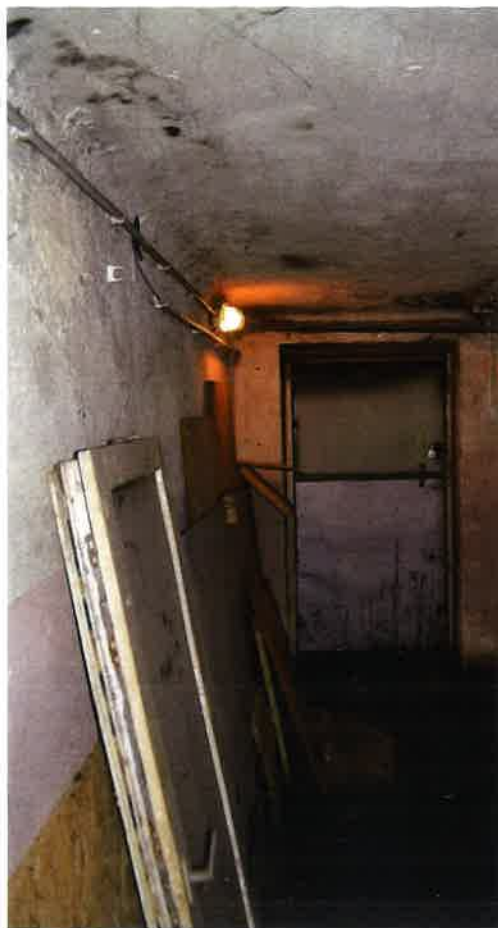
II. 49 Korytarz piwniczny
