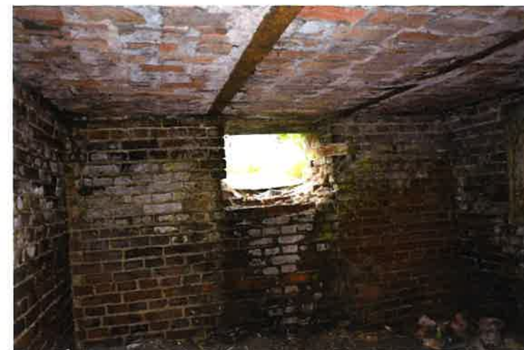
II. 50-51 Komórka piwniczna w zachodniej części budynku
