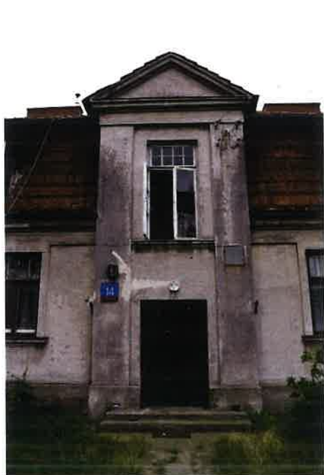
Il. 14 Pseudoryzalit głównego wejścia
