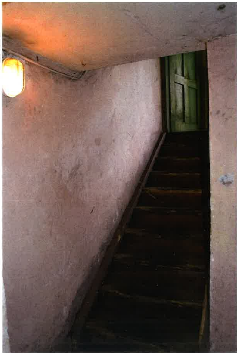
II. 48 Schody do piwnicy
