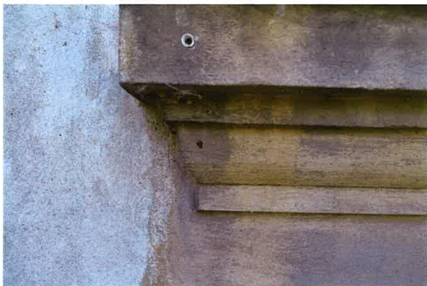
II. 18 Detal architektoniczny elewacji- gzyms podokienny
