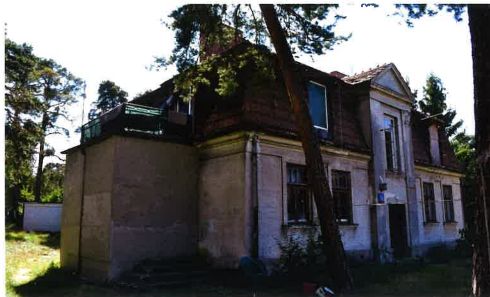
II. 9 Elewacja frontowa, widok od strony wschodniej
