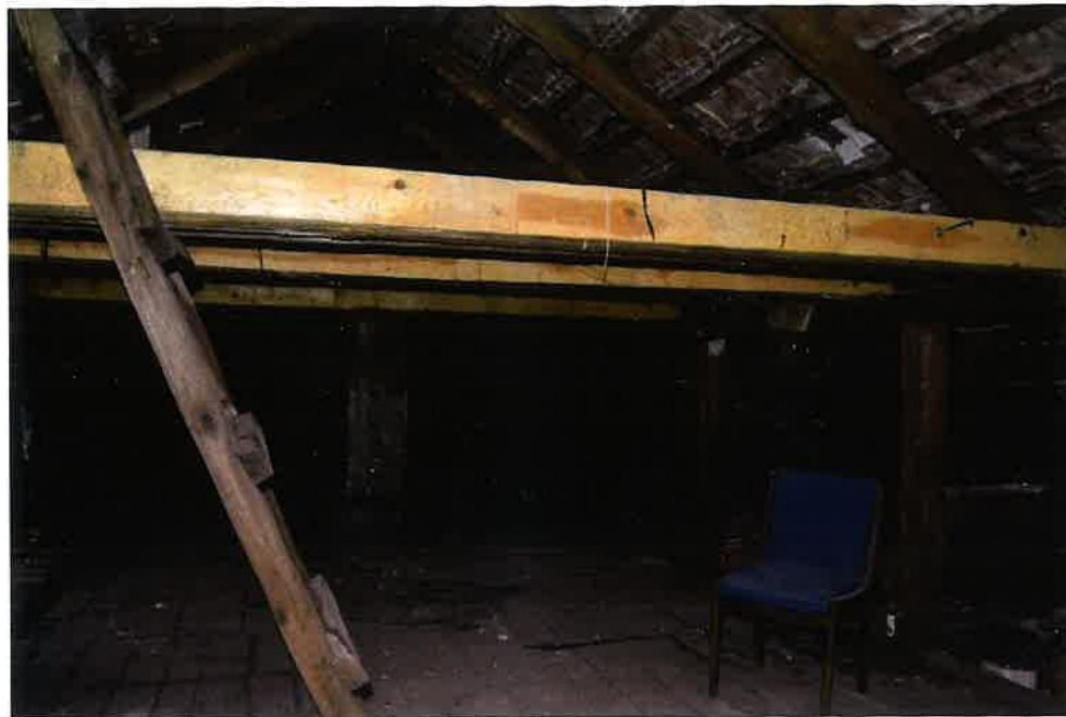
II. 53 Poddasze, widoczna więźba drewniana, z przodu drabina prowadząca na dach
