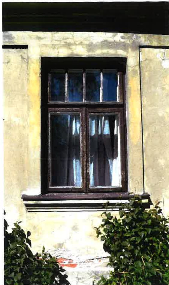
II. 23 Oryginalne okno w lokalu mieszkalnym
