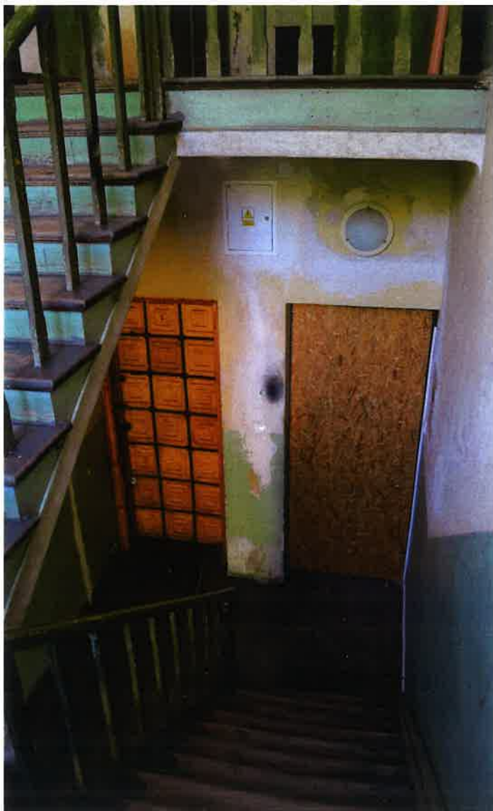
II. 27 Klatka schodowa, widok na drzwi do lokali nr 1 i 2
