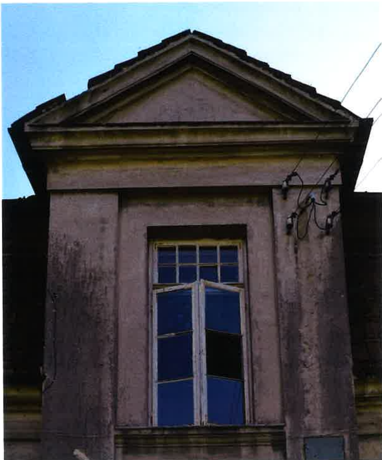
II. 22 Oryginalna stolarka okienna na klatce schodowej
